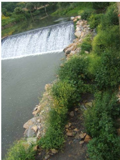
Fig. 4.11.1.5 Rampa in pietra sulla diga di Guado della spina
